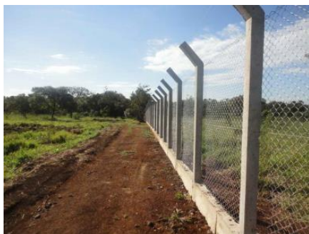
Figura 6 (a+b) - Tipos de cercamento a serem utilizados no aterro (a) Cercamento com moeirão de concreto, (b) Cercamento com coluna em tubo de aço.
